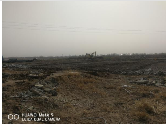
梁场、拌和站场地平整
