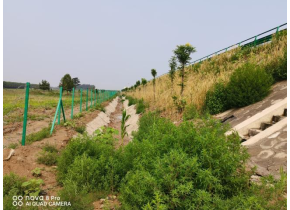
公路两侧绿化与排水沟
