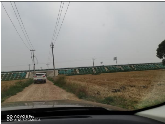
边坡临时覆盖植草
