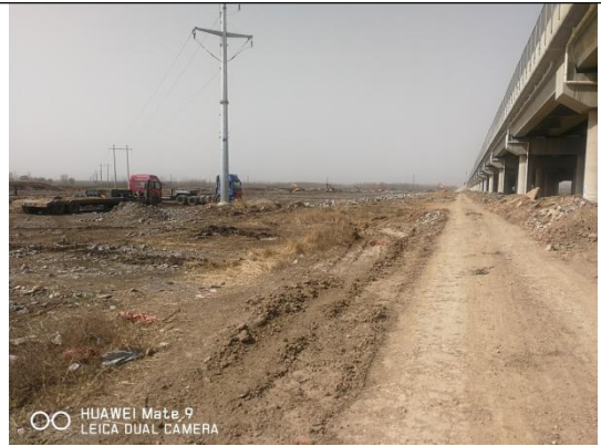
梁场、拌和站场地平整
