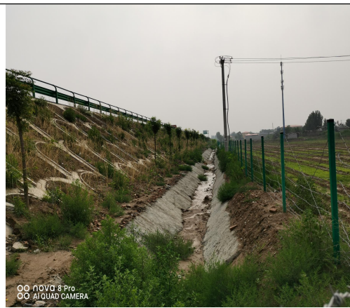
3 标边坡防护与绿化（施工便道）
