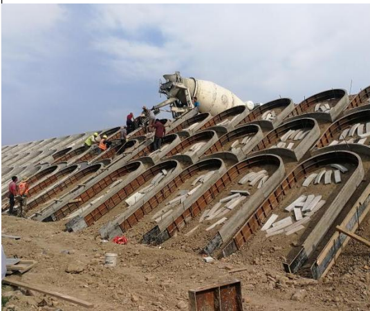
拱形护坡施工
