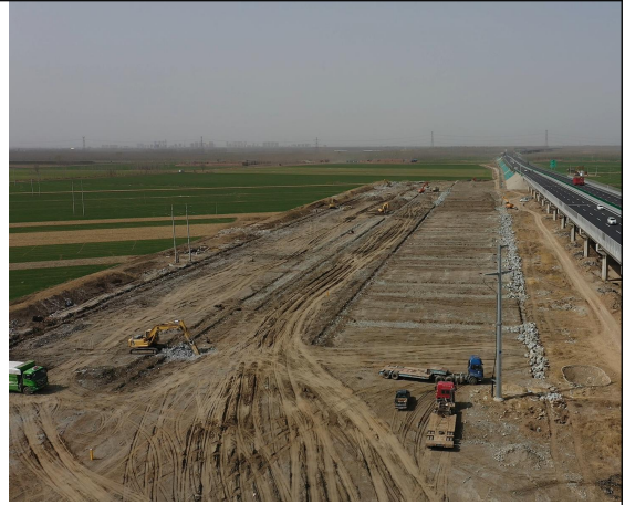
梁场、拌和站场地平整
