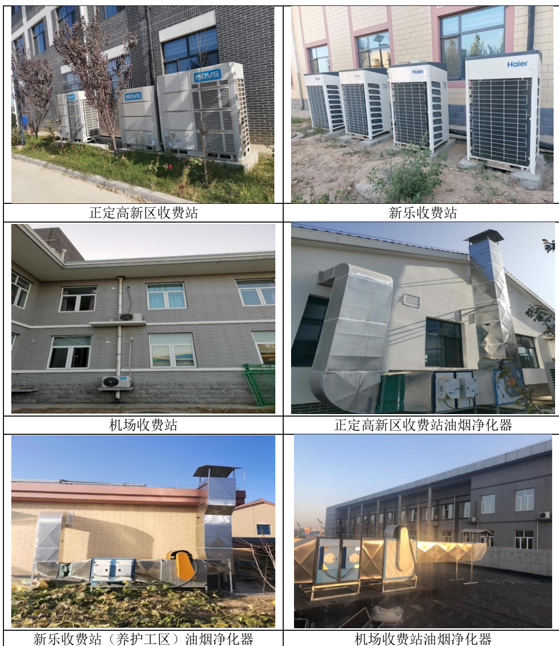
图 8.2-1 空调装置及油烟净化器
