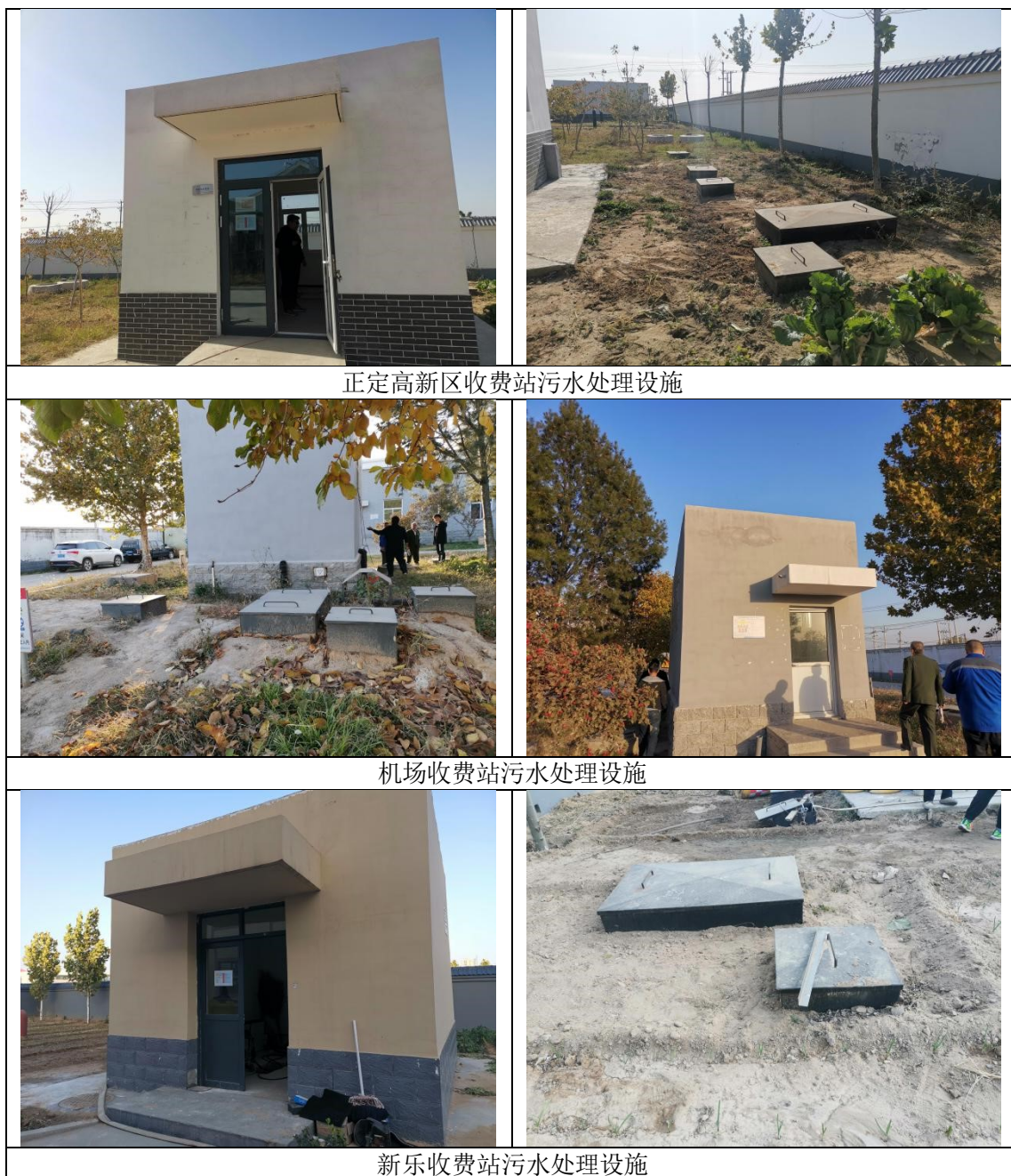
图 7.3-3 沿线收费站污水处理站
